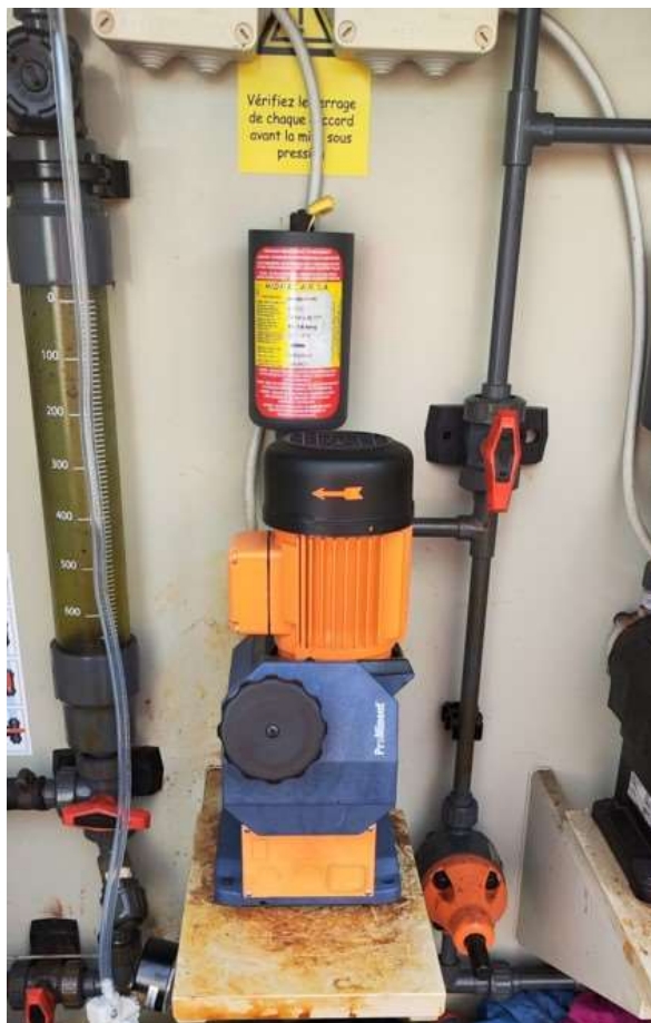
Remplacement pompe injection chlorure ferrique :
