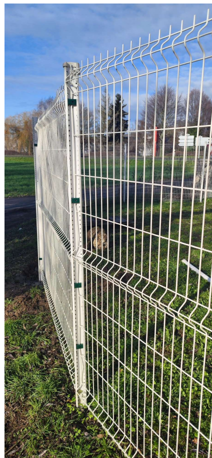
Réparation clôture suite accident :
