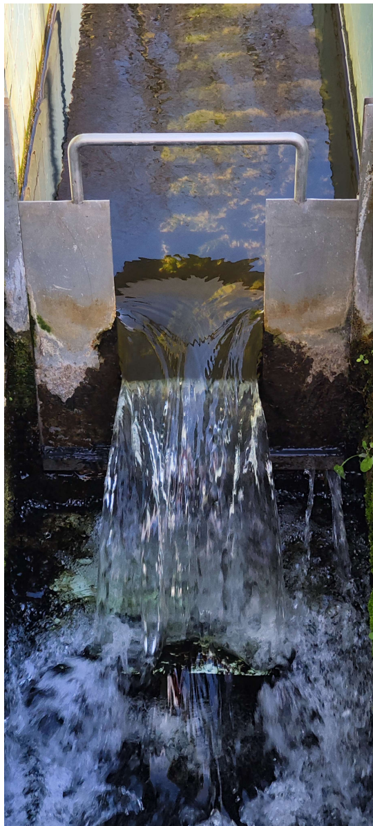
Remplacement de la lame de sortie du canal :
