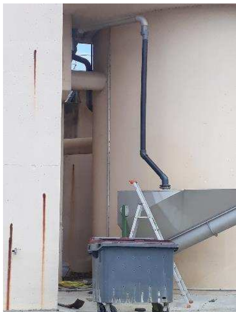
Pose de tuyauteries d'alimentation et de surverse du classificateur en PVC pression
