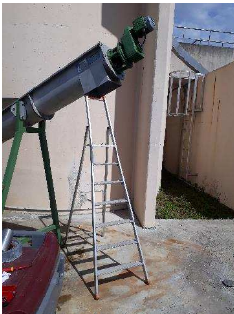
Démontage de la vis du classificateur : changement tresses et nettoyage graissage des paliers
