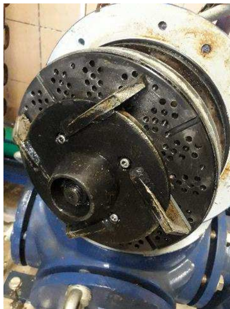
Démontage dilacérateur et nettoyage complet
