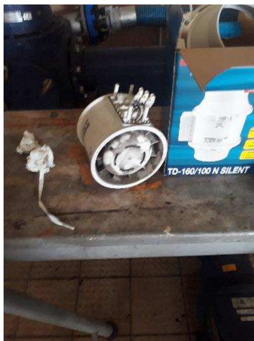
Mise en place d'un nouveau moteur de ventilation pour refroidir l'armoire déshydratation
