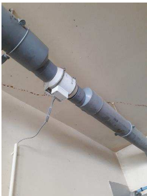
Mise en place d'un nouveau moteur de ventilation pour refroidir l'armoire déshydratation
